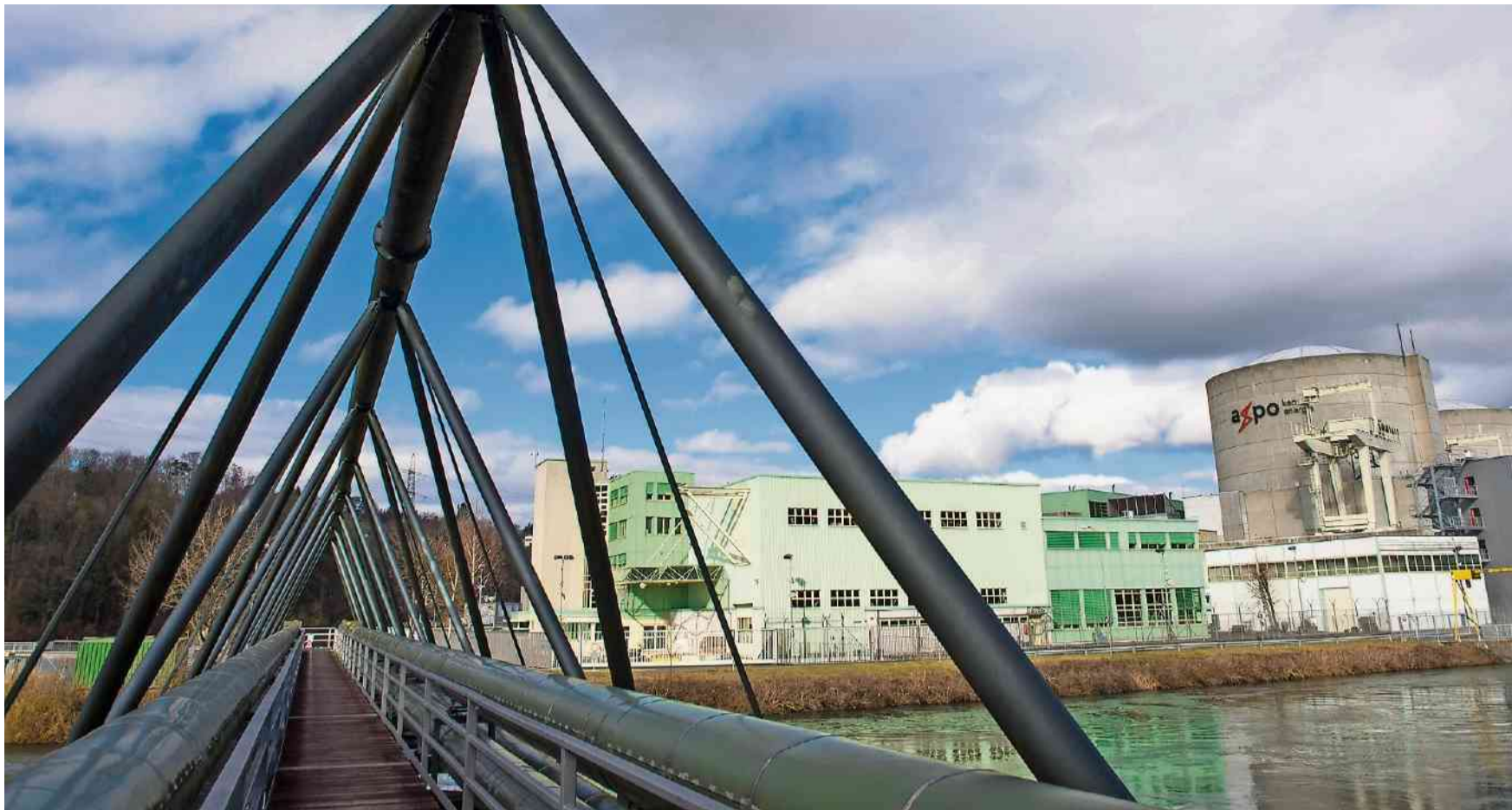
Wie lange die Refuna-Nutzer noch Fernwärme der Atomkraftwerke Beznau beziehen, ist ungewiss.
